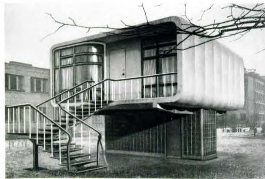
Bild 165 Experimentalhaus aus Plasten in Leningrad. Leningrader Außenstelle der ASiA der UdSSR
