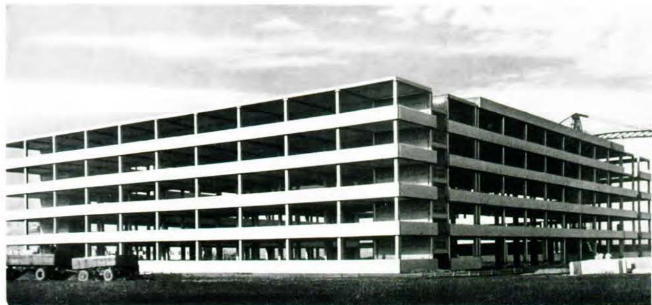
Bild 161 Skelettkonstruktion in Montagebauweise, Stützabstand 6 m x 6 m
