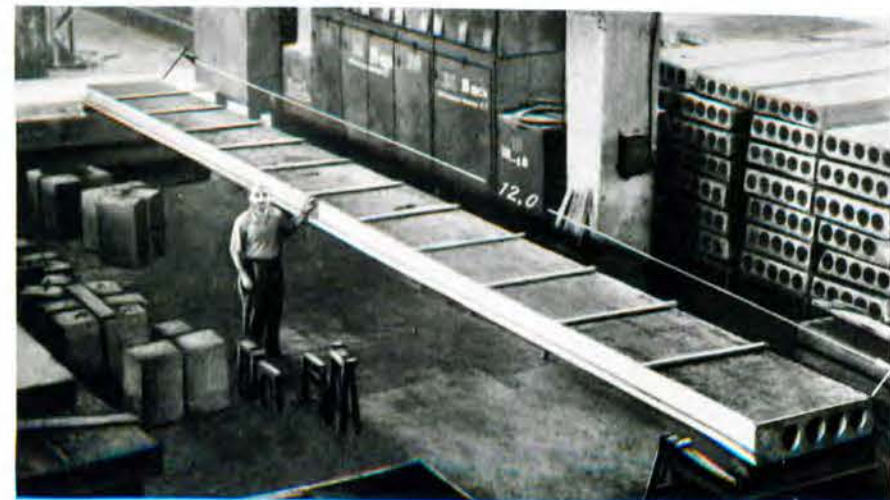
Bild 162 Hohldeckenelement
