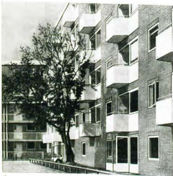
Bild 43 Kollektivhaus „Hoje Seeborg“ in Kopenhagen. Architekten: P. Hoff und B. Windinge. 1951
