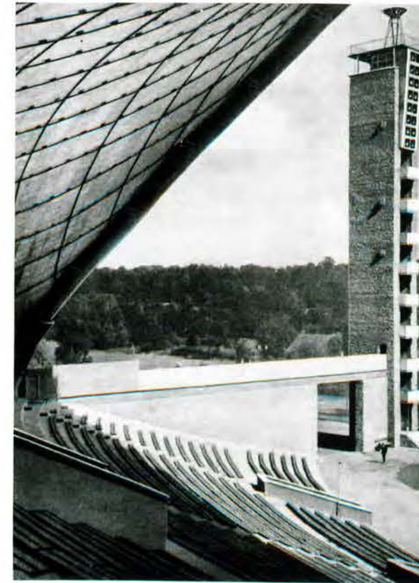
Bild 163 Seilnetzkonstruktion der Sängerbühne in Tallinn, Architekt: A. Kotli; Ingenieur: E. Paalman
